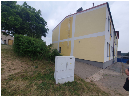
Elektro pilíř – nutno upravit polohu vč. trasy vedení (zajišťuje ČEZ Distribuce)
