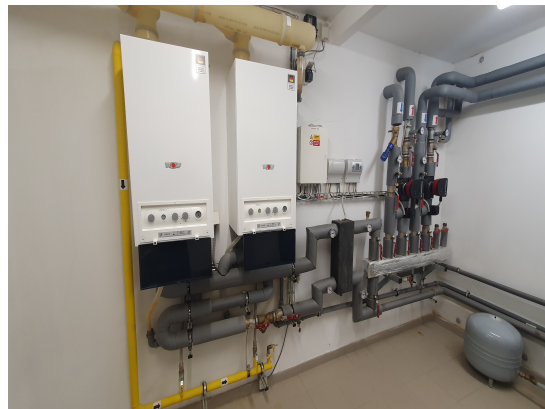
Kotelna v hlavního objektu – prostor napojení soustavy vytápění pro nový pavilon
