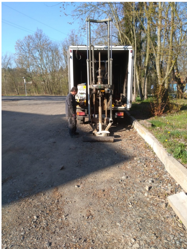
Foto 1 : realizace vsakovací sondy HV 2
